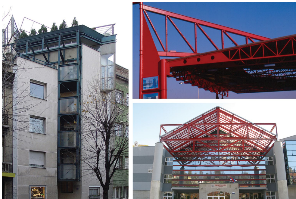
Slika 5. Zgrada u Višegradskoj 12a (levo), škola u Užicu (dole desno) i pumpa „Jugopetrol“ (gore desno), oko 1997, arhiva B. M.
